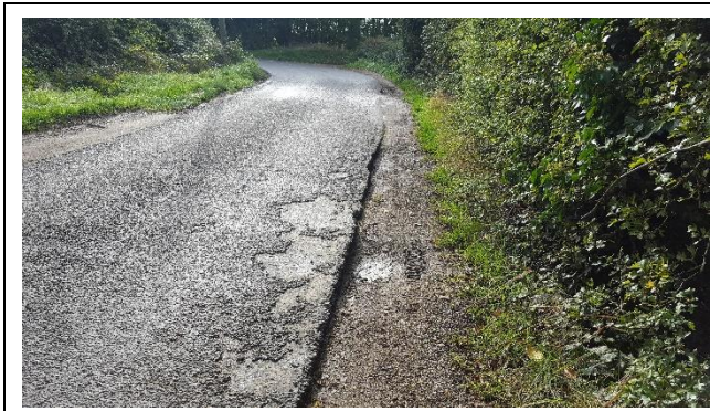
Edge deterioration
