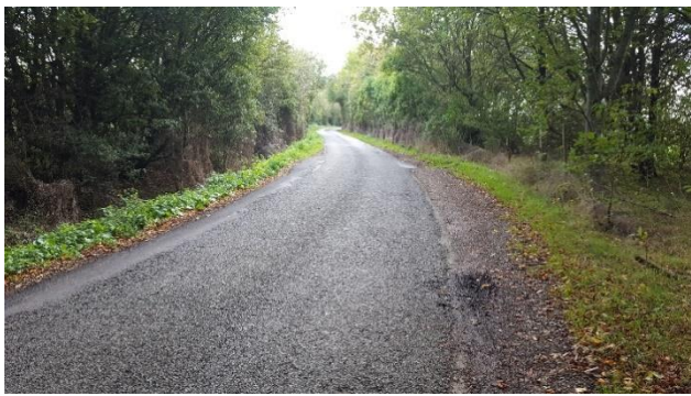
Edge deterioration
